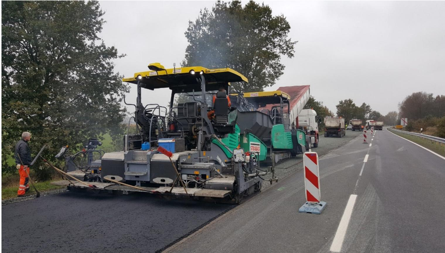
Kontinuierliche Belieferung des Asphalt-Fertigers mit Asphaltmischgut
